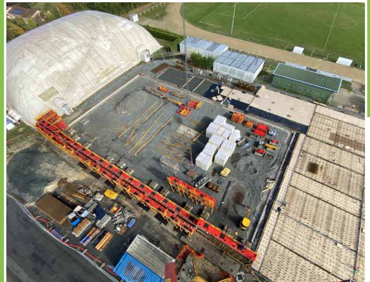
Construction du complexe sportif - Brioux-sur-Boutonne - octobre 2024
