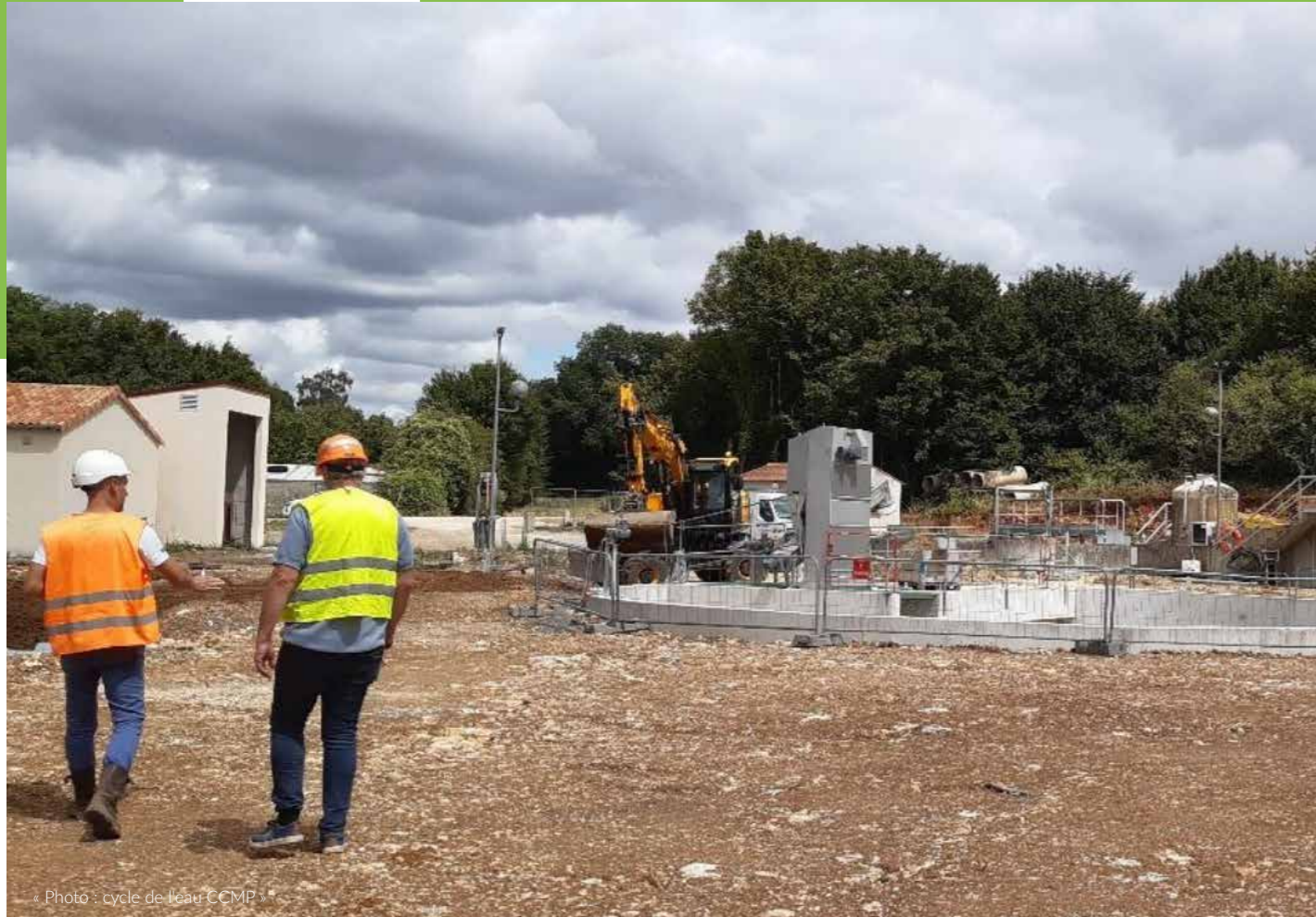
Travaux de la station d'épuration - Sauzé-Vaussais - 2024
