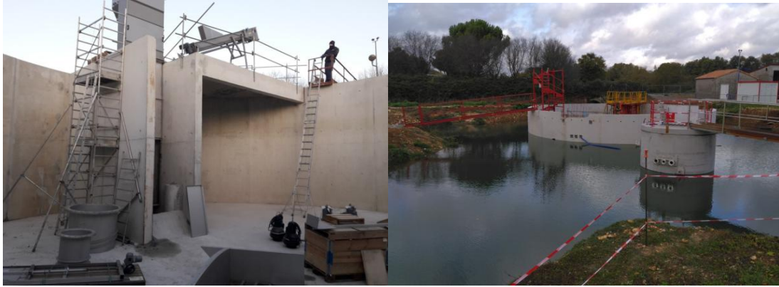
Figure 32: Illustrations des travaux en cours à la STEP
