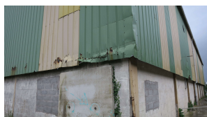
Hangar ouvert de 768 m 2 en parpaings et bardage en tôle simple peau en mauvais état d'entretien ;
