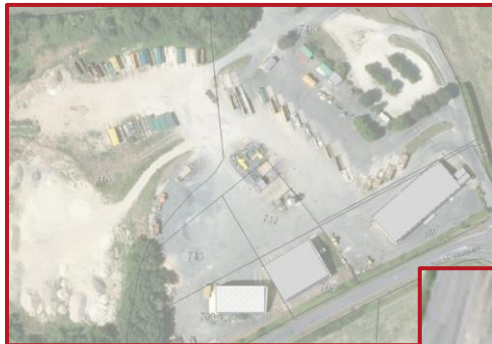
Chef Boutonne – Locaux SIVU : Equipe régie bâtiment
