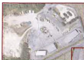
Chef Boutonne - Locaux SIVU Equipe régie bâtiment
