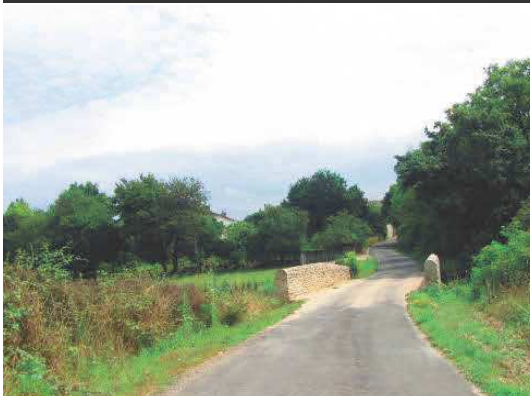
Pont en pierre (voie communale)
