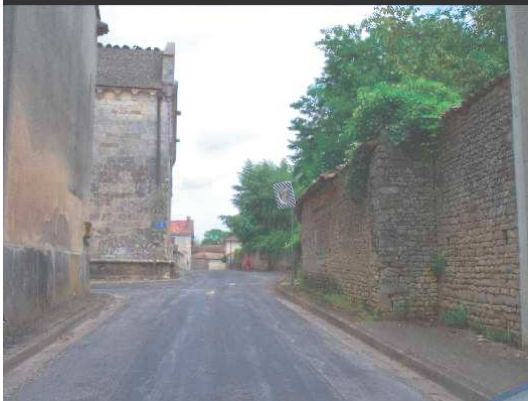
Mur en pierre (parcelle n°93)
