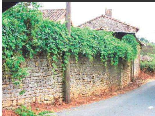
Mur en pierre (parcelle n°738)
