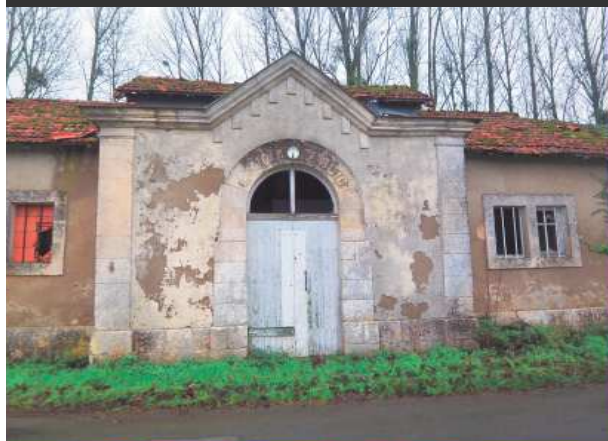
Ancien lavoir (parcelle n°54, Route de Maire-Levescault )
