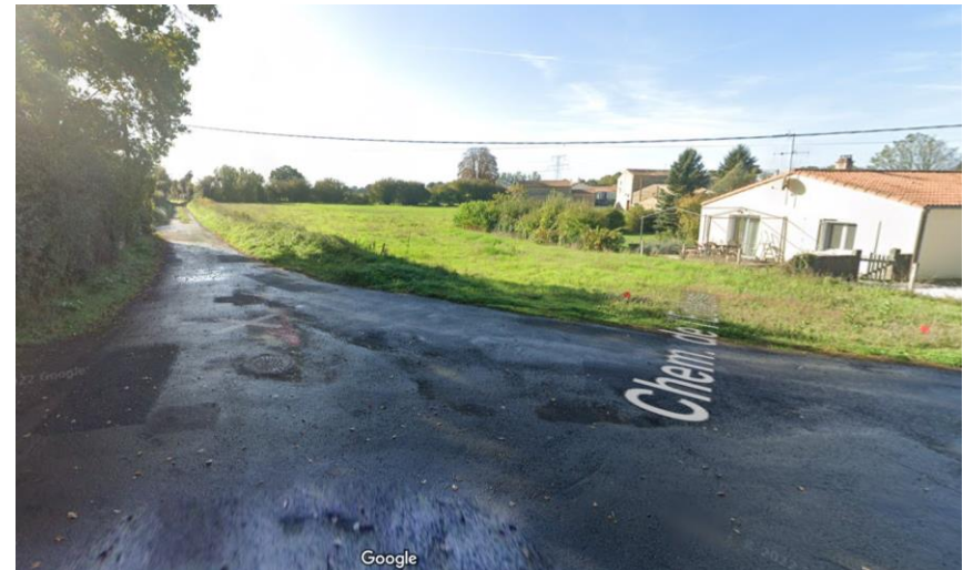
Chemin de l'éolienne – Vue vers le secteur initialement fléché au zonage du PLU pour l'emplacement réservé n°5
