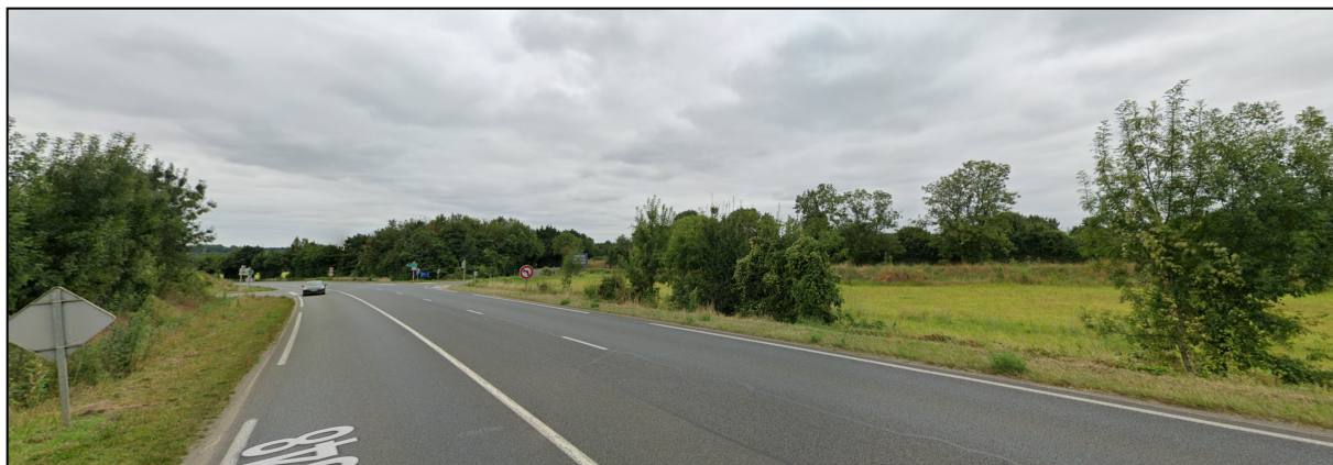
Vue depuis la RD, vers le sud
