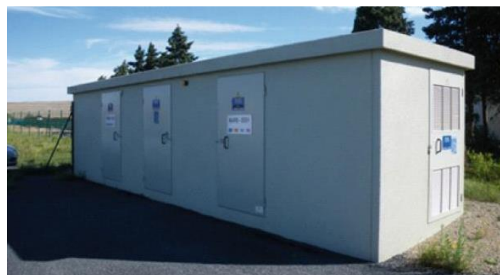
Photographie 4 : Exemple de poste de livraison (Source : ENCIS Environnement)
