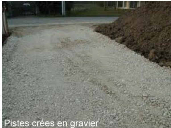
Photographie 6 : Exemple de pistes empierrées (Source : ENCIS Environnement)
