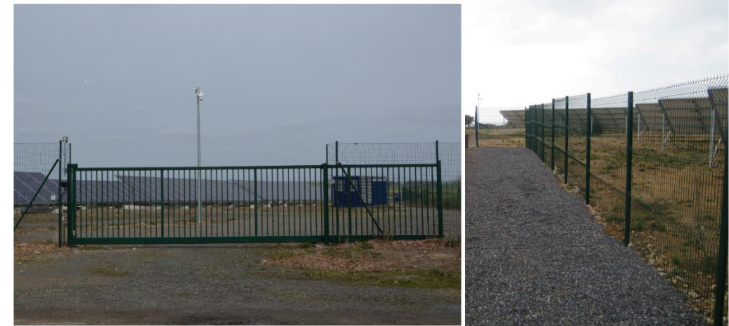
Photographie 7 : Exemple de clôture de sécurité et portail d'accès (Source : ENCIS Environnement)
