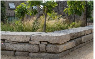
réemploi des pierres d'angle - @atelier L
