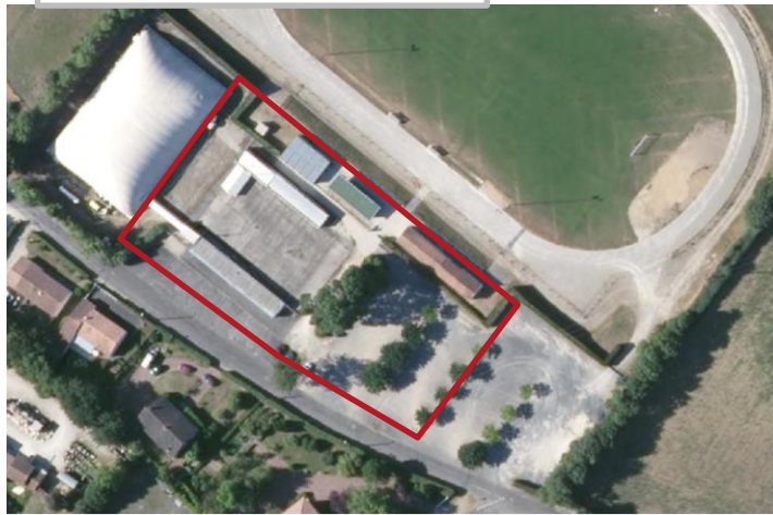
Le site avant travaux
