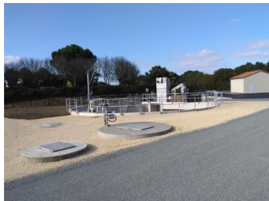
Figure 33: Illustrations des travaux en cours à la STEP de Sauzé entre Bois
