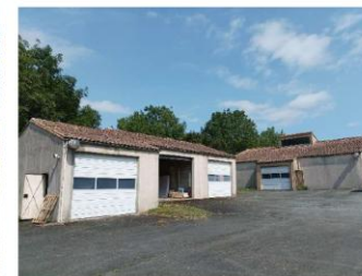
Vue sur le garage ouest
